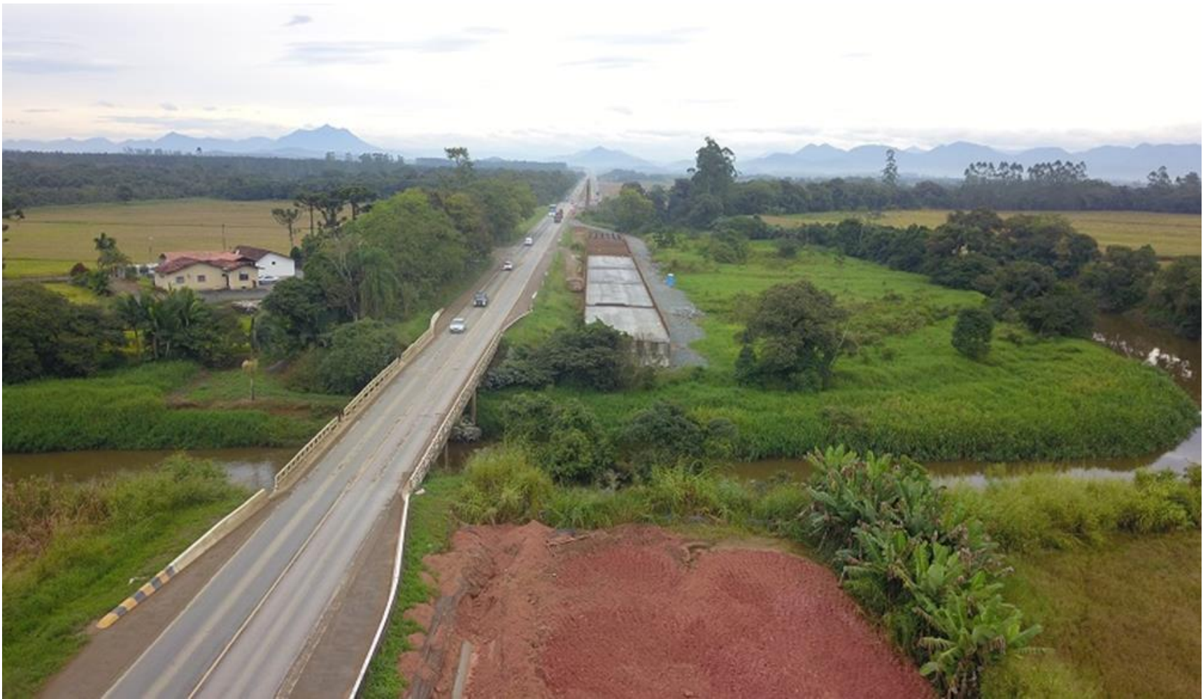
36 – Construção da Nova Ponte sobre o Rio Pirai
