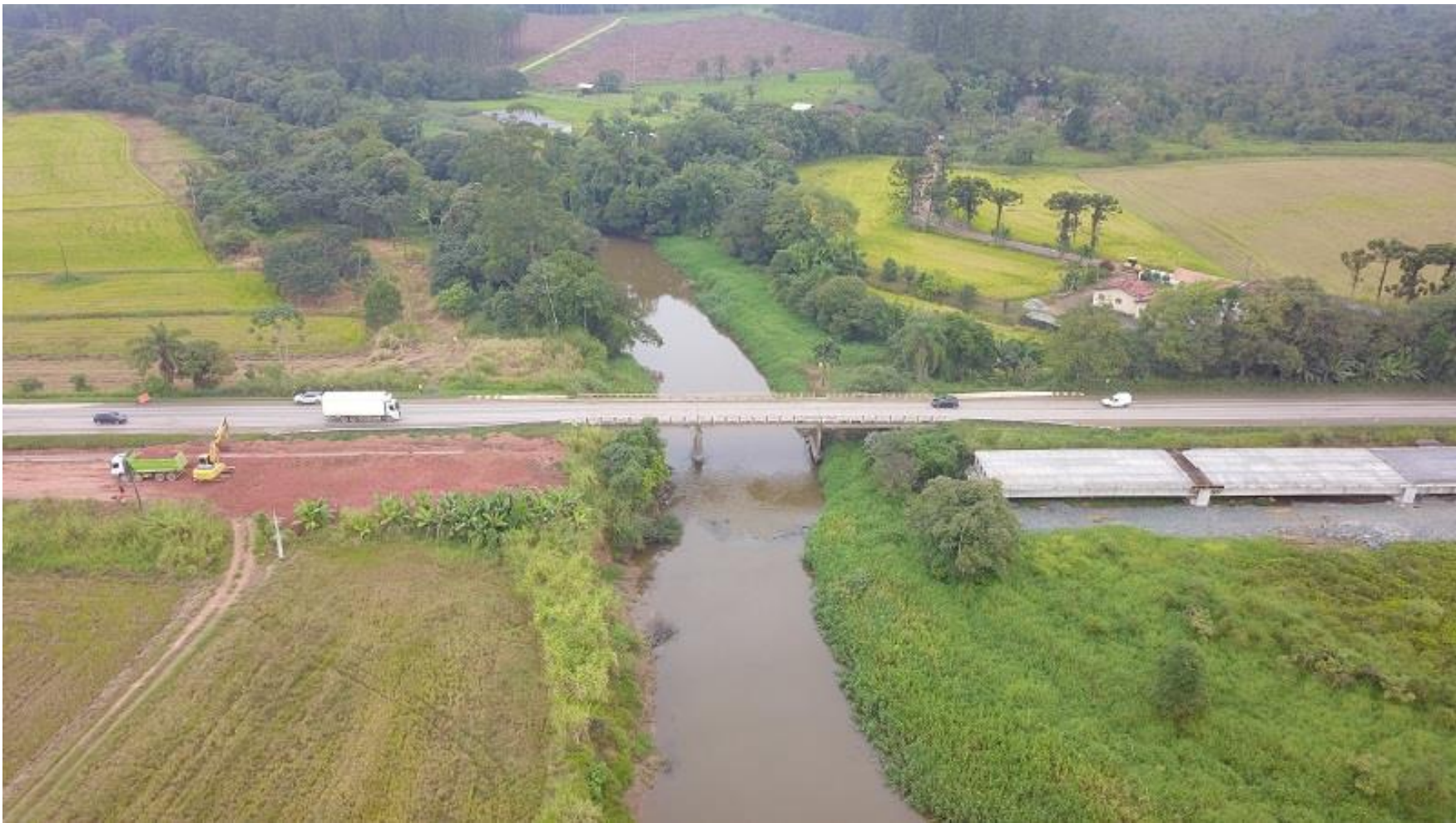
38 – Vigas Pré-Fabricadas no Canteiro de Obras
