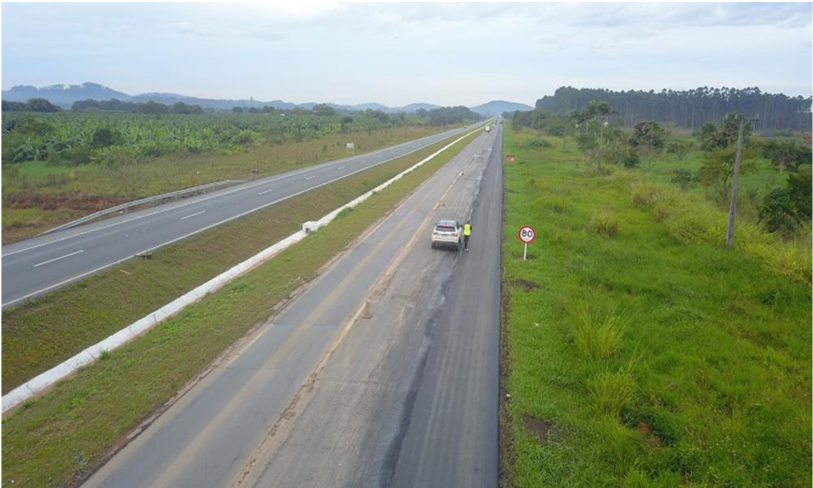
35 – Recuperação, Recapeamento e Sinalização da pista antiga da BR-280/SC
