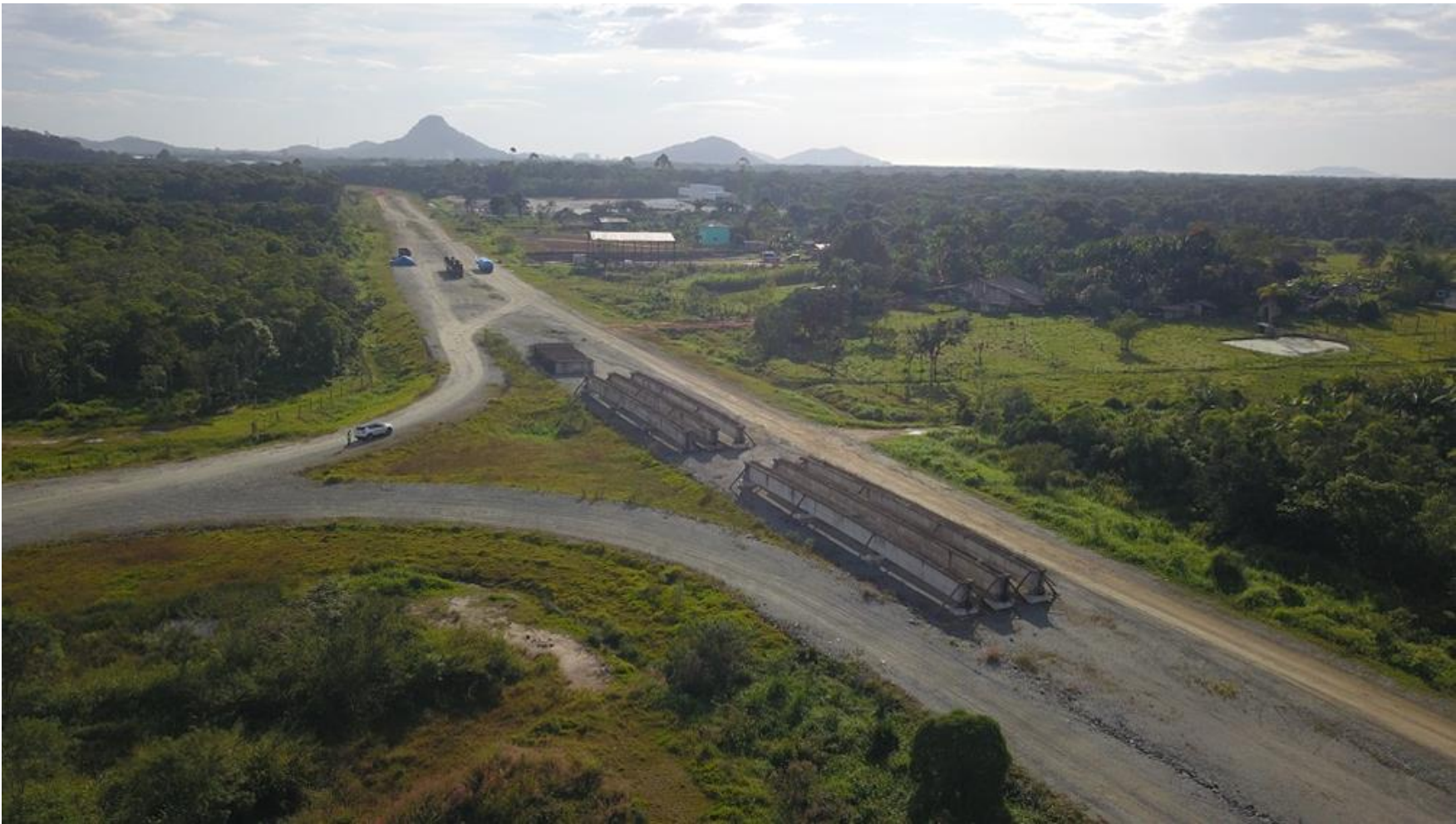
10 – Vigas Pré-Fabricadas Depositadas no Contorno de São Francisco do Sul.
