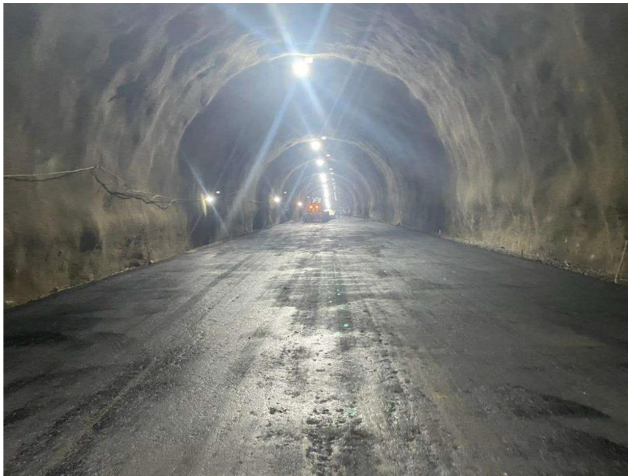
52 – Execução do Pavimento Rígido no Túnel Duplo – Extensão 1.070 Metros.
