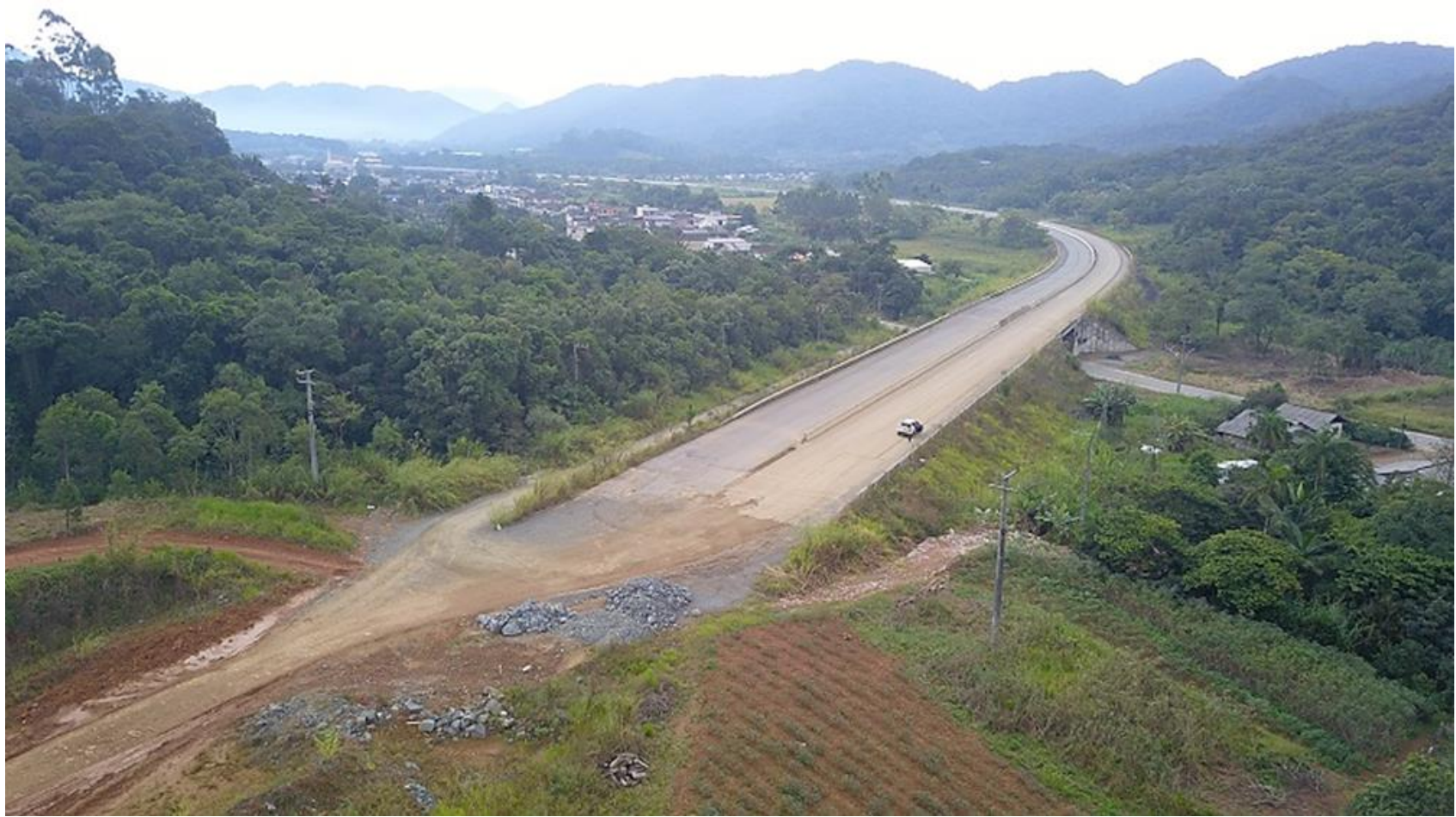
44 – Início do Segmento Duplicado – Contorno de Schroeder, com passagem superior no KM 52,07
