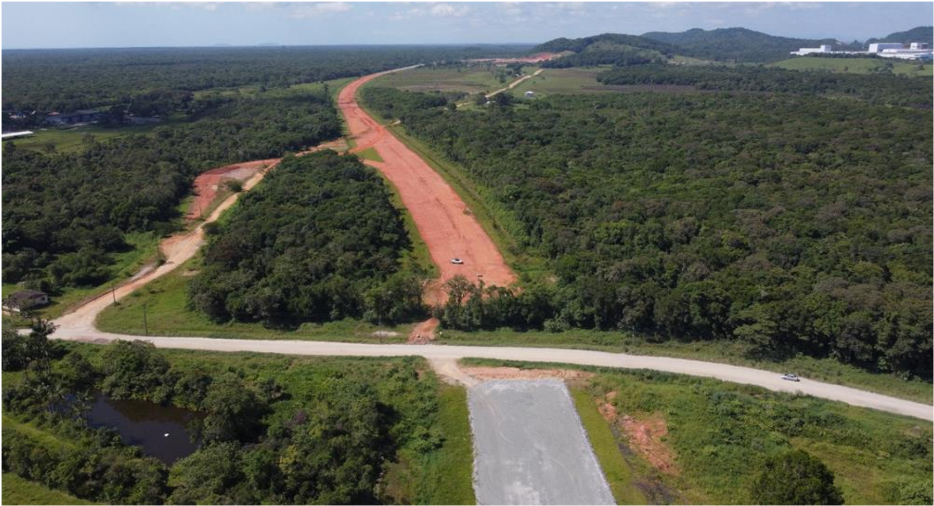
6 – Vista Parcial da Implantação do Contorno de São Francisco do Sul da BR-280/SC
