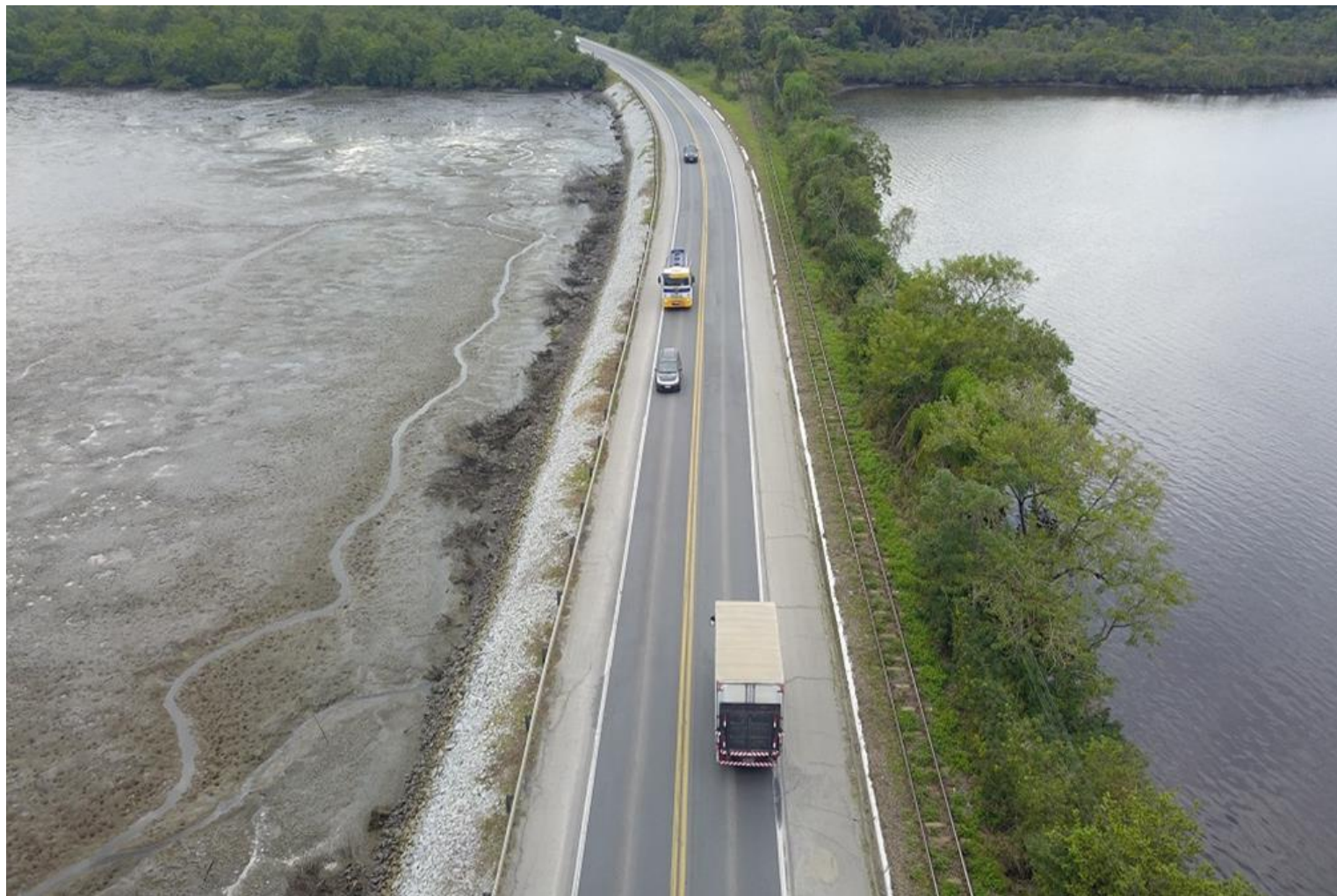
23 – Vista do Outro Aterro Rodoferroviário
