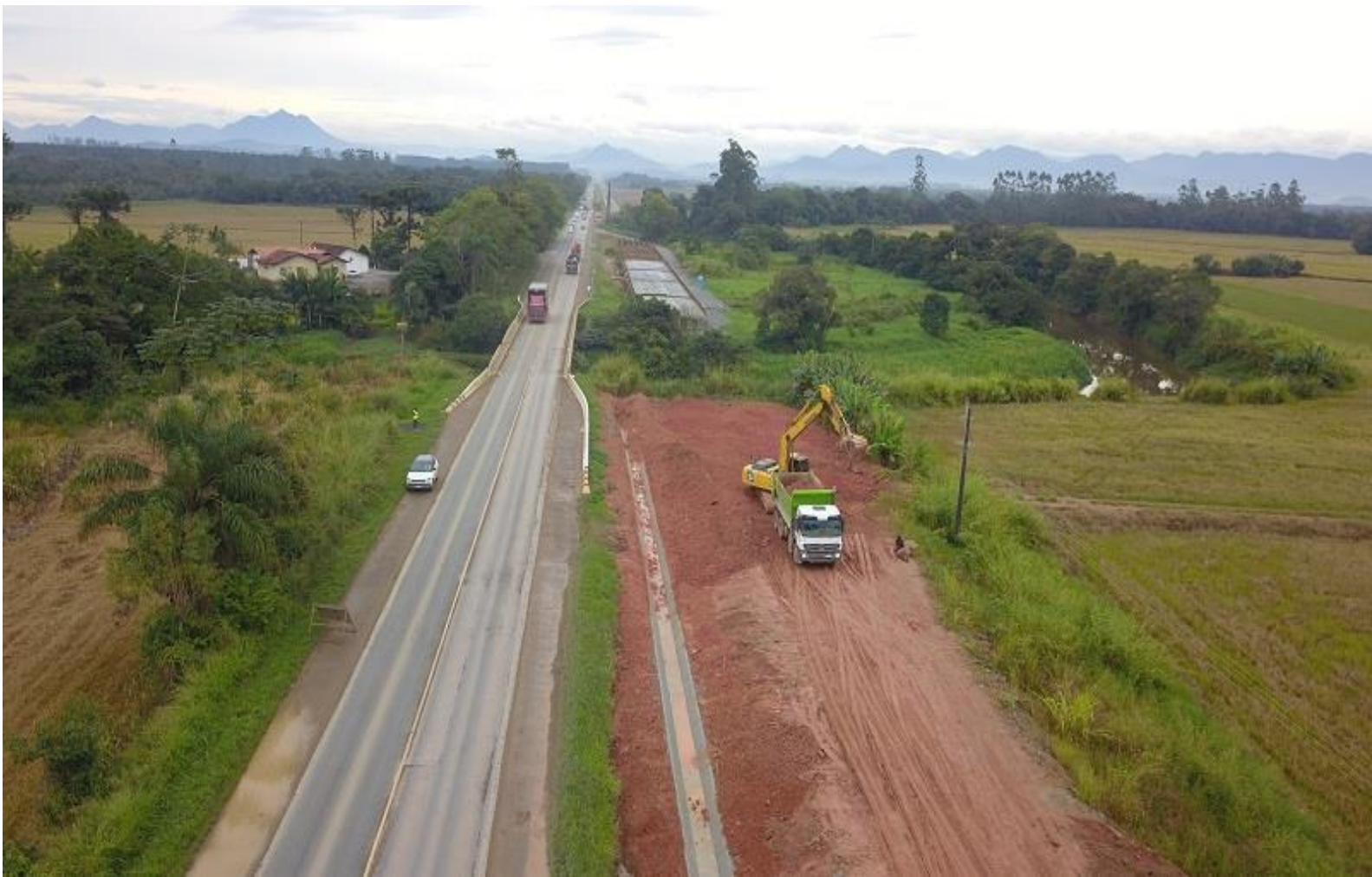
37 – Vista do Aterro da Nova Pista na Cabeceira Leste da Ponte Sobre o Rio Pirai
