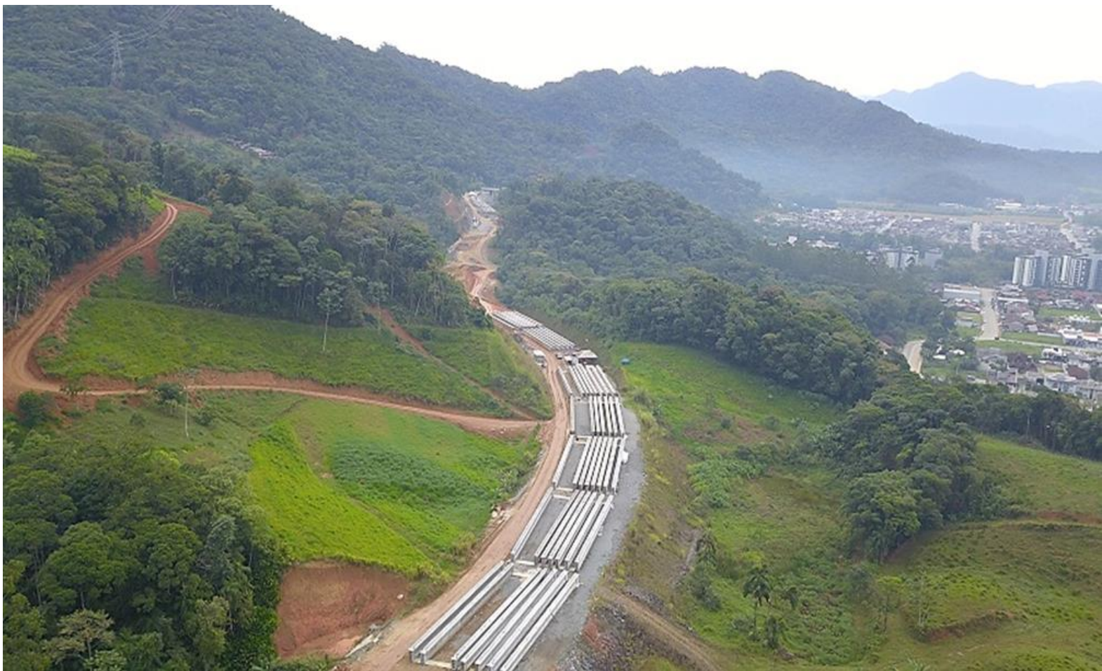
48 – Vista de Vigas Pré-Fabricadas no Canteiro de Obras (Total 220 Unidades)
