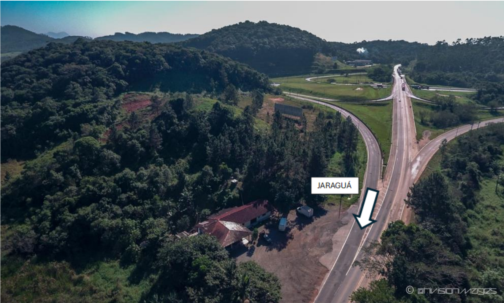
28 – Início do Lote 2.1 ( KM 36,7)
