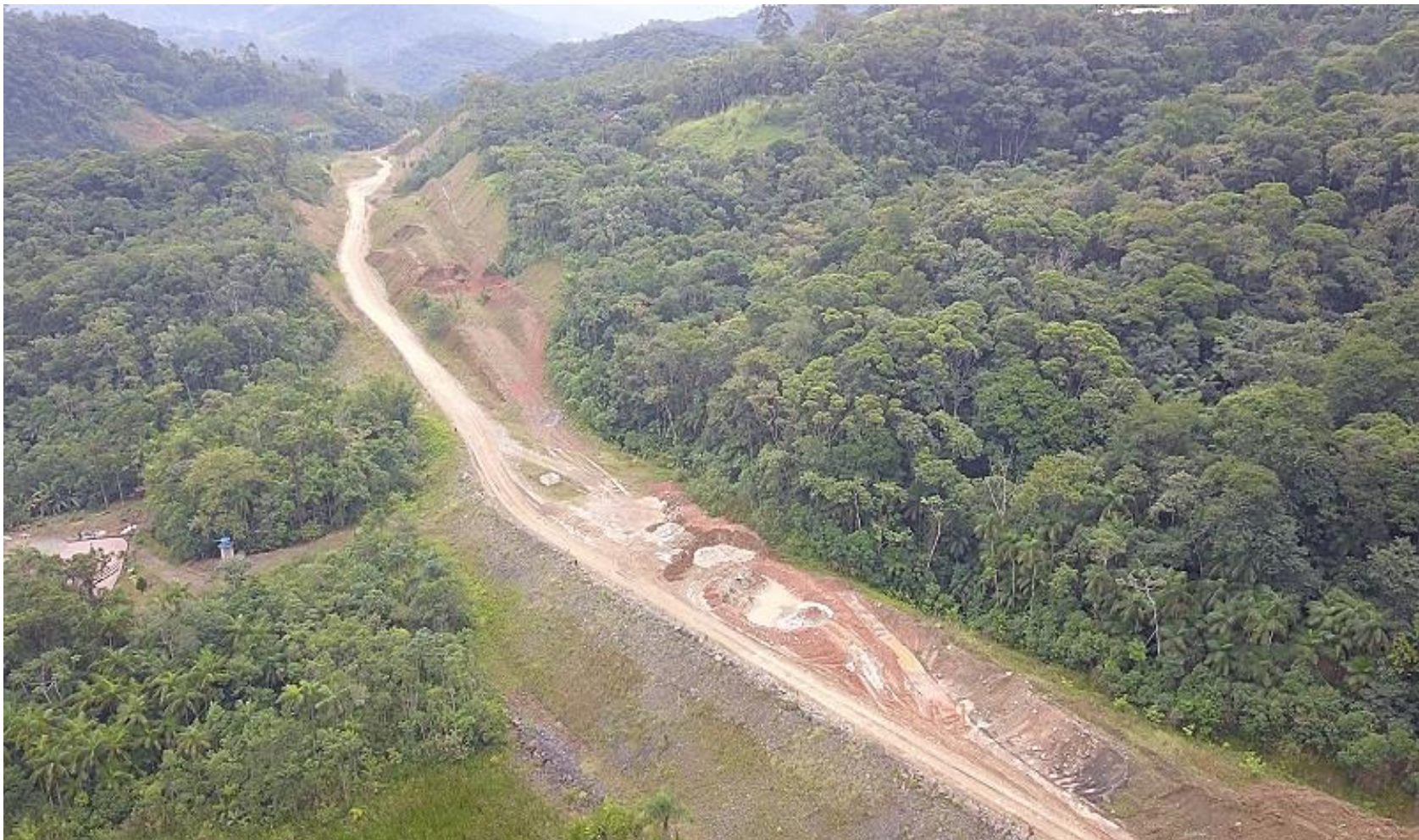
56 – Terraplanagem, em Execução, no segmento do embocamento do Túnel à Localidade de Três Rios do Norte (2,40 KM).
