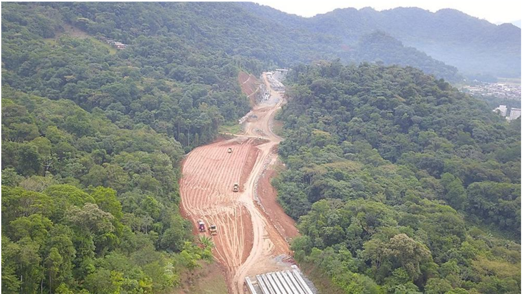
49 – Terraplanagem do Segmento, em execução.
