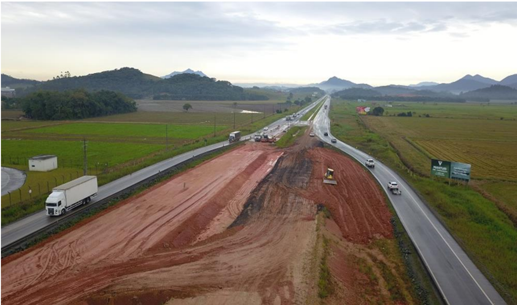
32 – Outra vista parcial das obras de infraestrutura para construção da passagem em desnível no KM 46,7.
