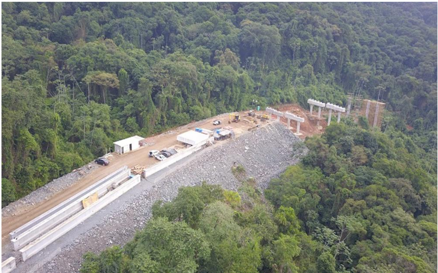
50 – Observa-se a construção das Infra e Meso Estrutura dos Viadutos de acesso ao embocamento “Leste” do Túnel sob o Morro Vieira.
