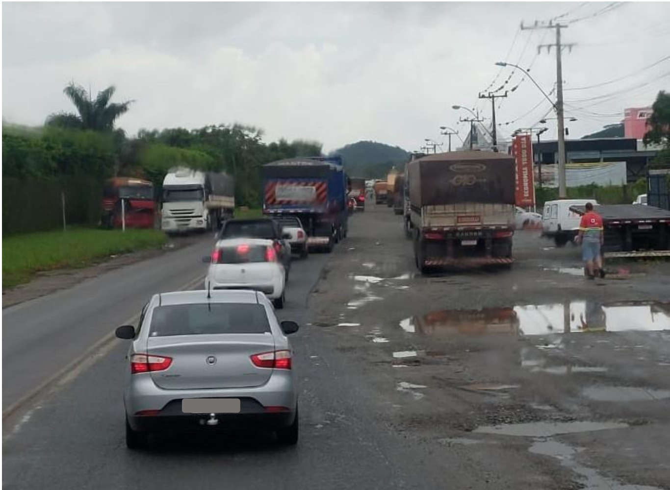
16 – Outra vista do trânsito no traçado atual da BR-280/SC
