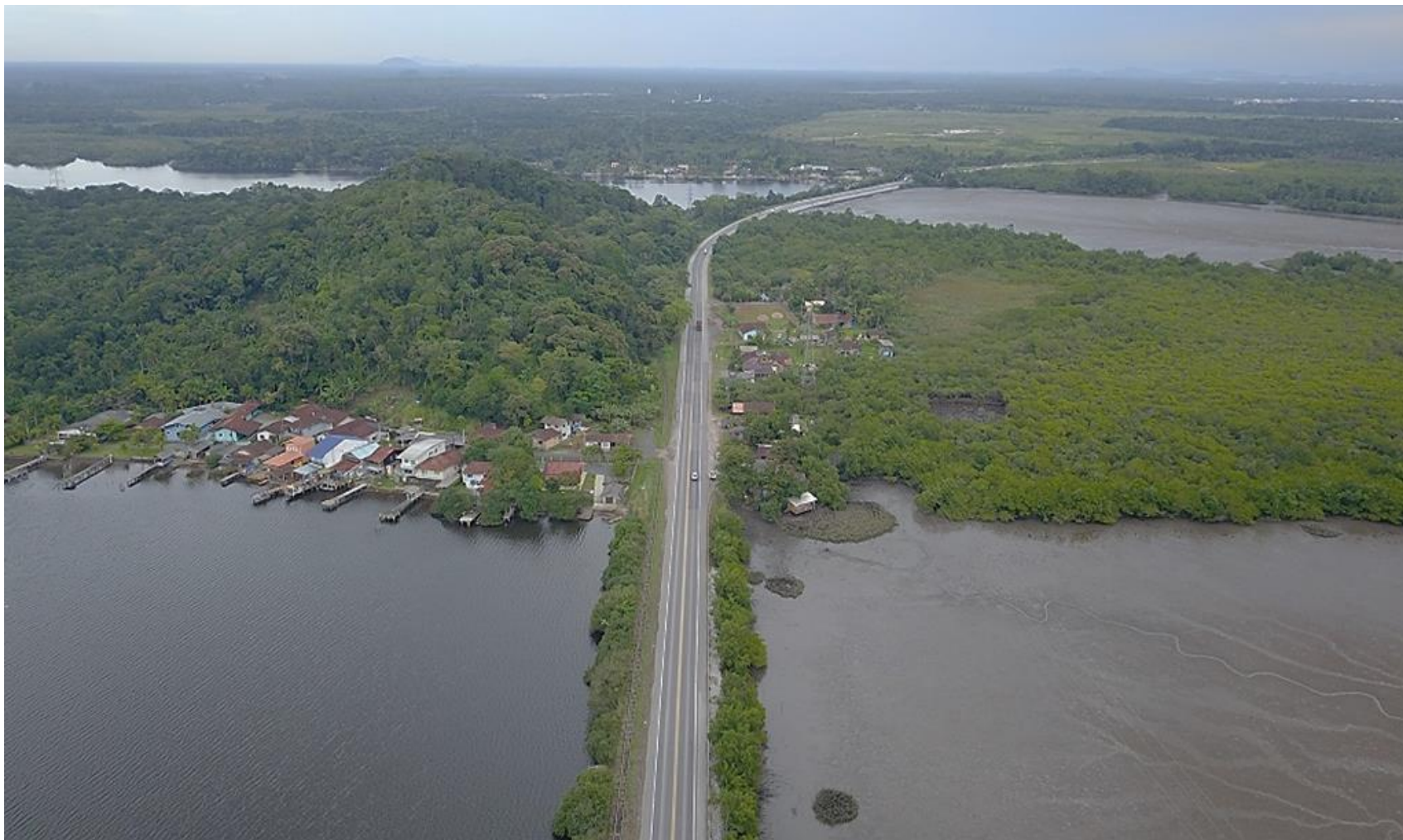
21 – Vista dos dois Aterros existentes sobre o Canal do Linguado
