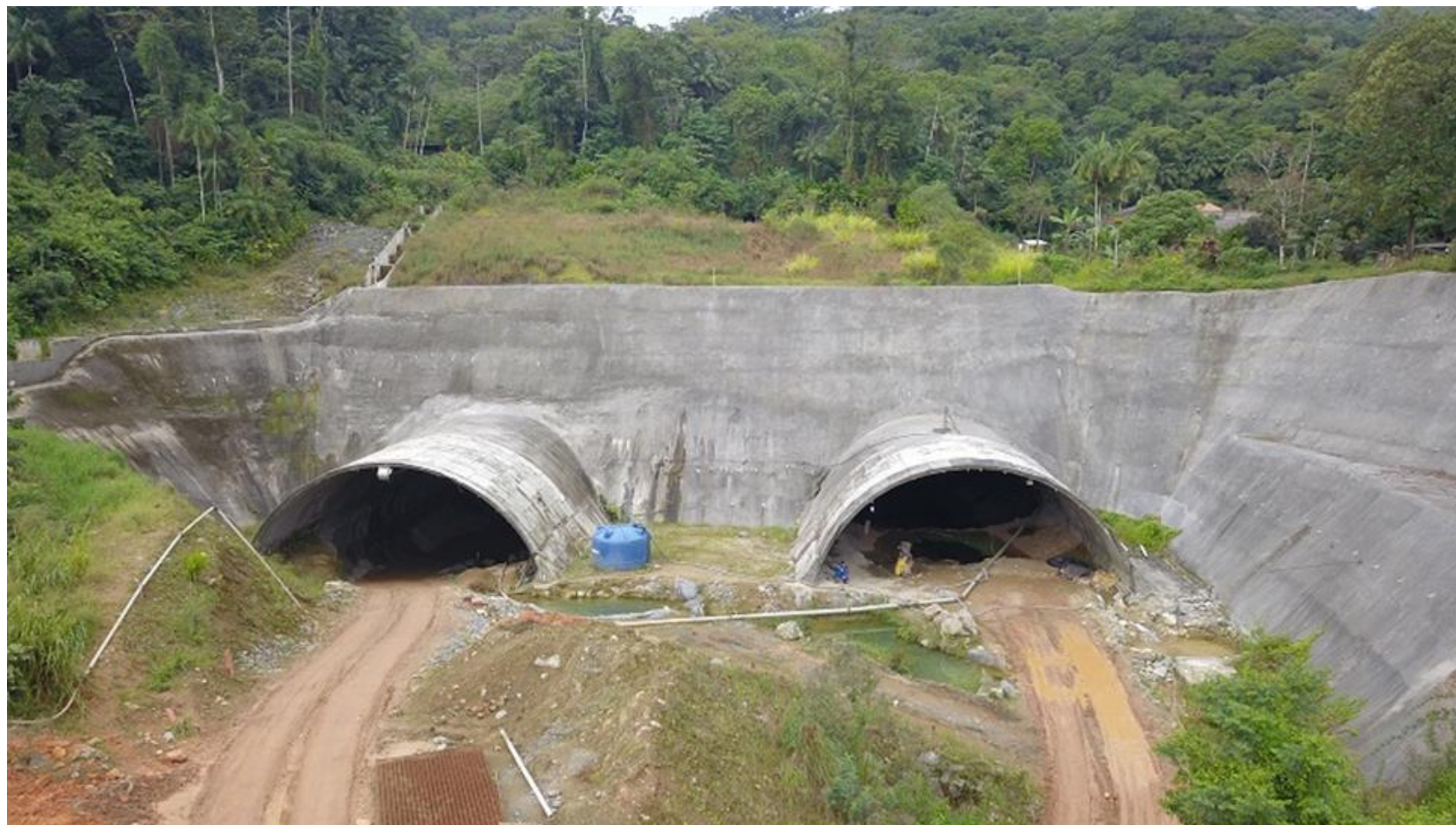
53 – Embocamento “Oeste” do Túnel Duplo – KM 66,680.
