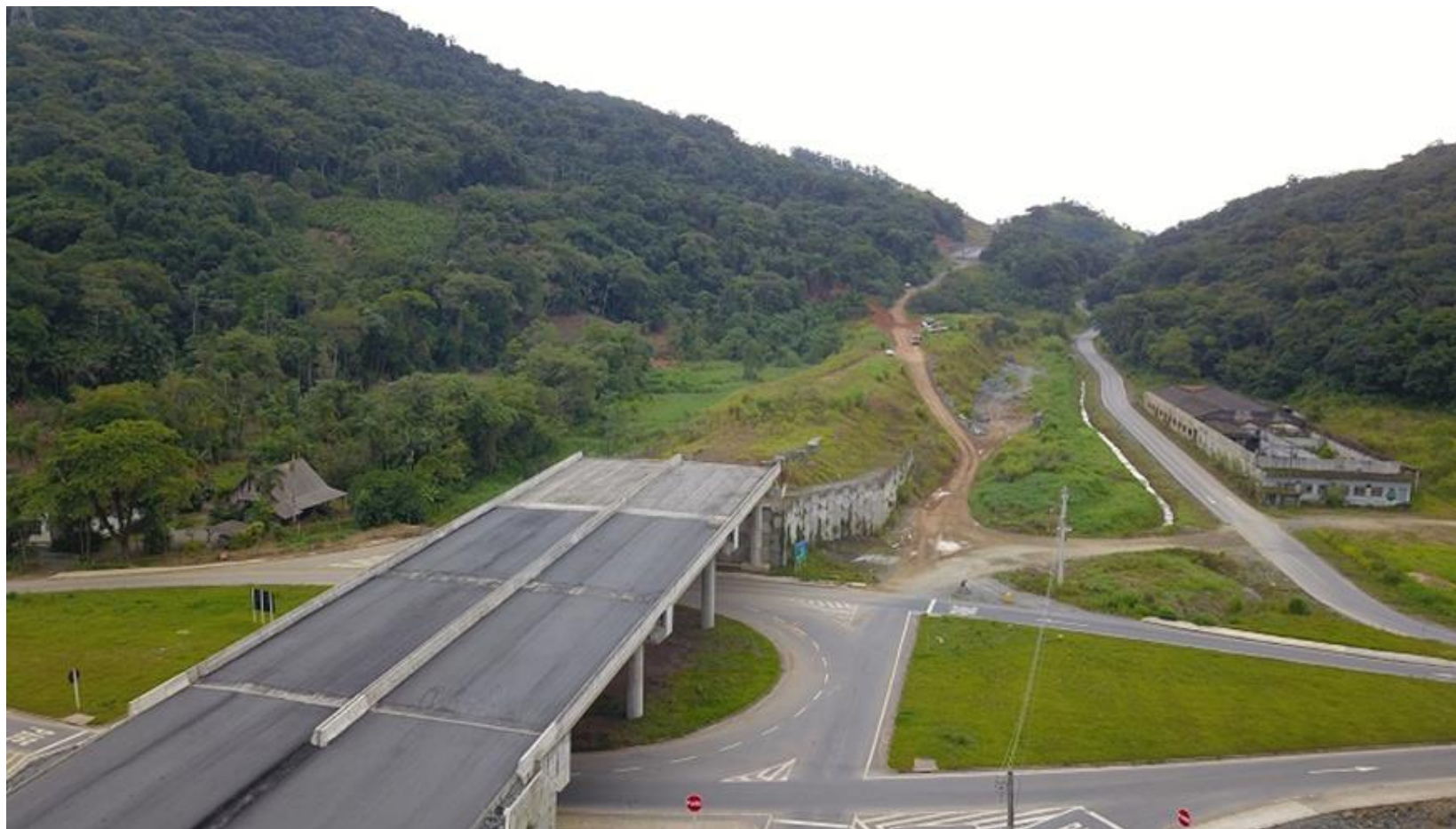
40 – Viaduto Sobre a Rodovia SC-108 (Rodovia do Arroz)
