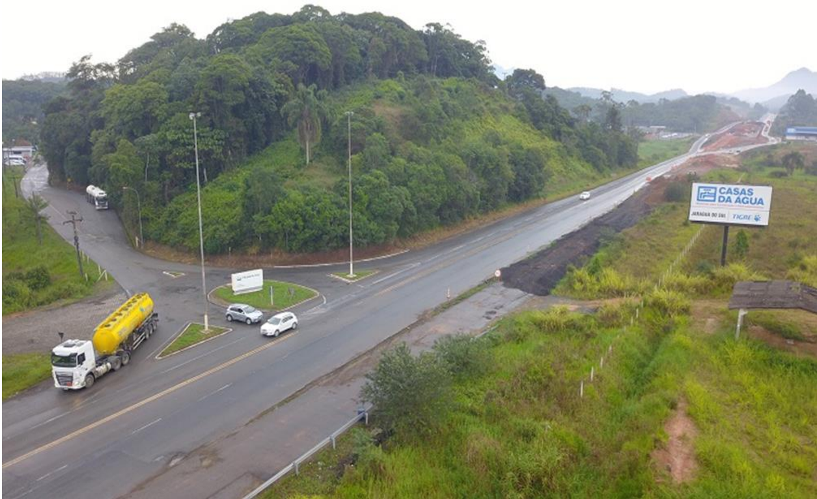
33 – Acesso ao Terminal da Transpetro
