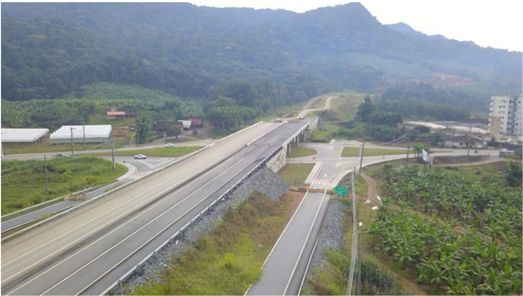
45 – Passagem Superior no KM 58,07 (Perímetro Urbano de Schroeder).
