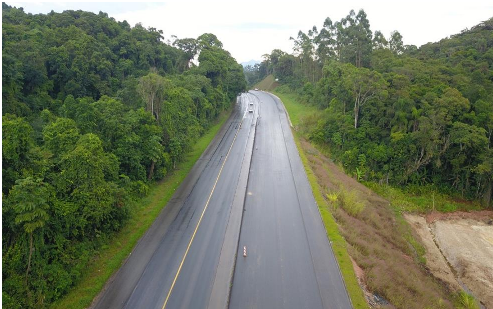
29 – Execução da Capa Asfáltica próximo do KM 40,0.
