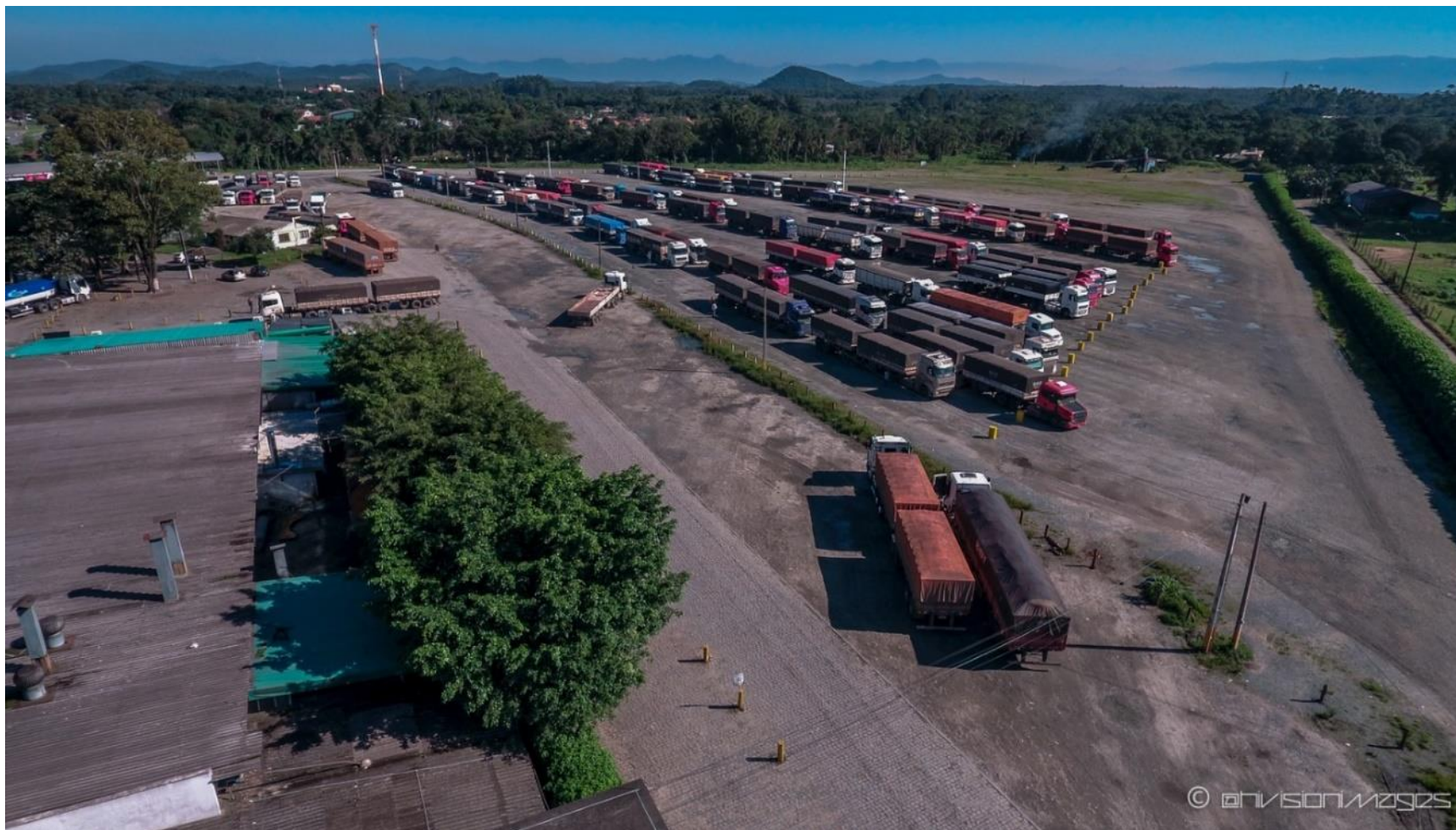
26 – Parque de Estacionamento de Caminhões, Aguardando Ordem Portuária
