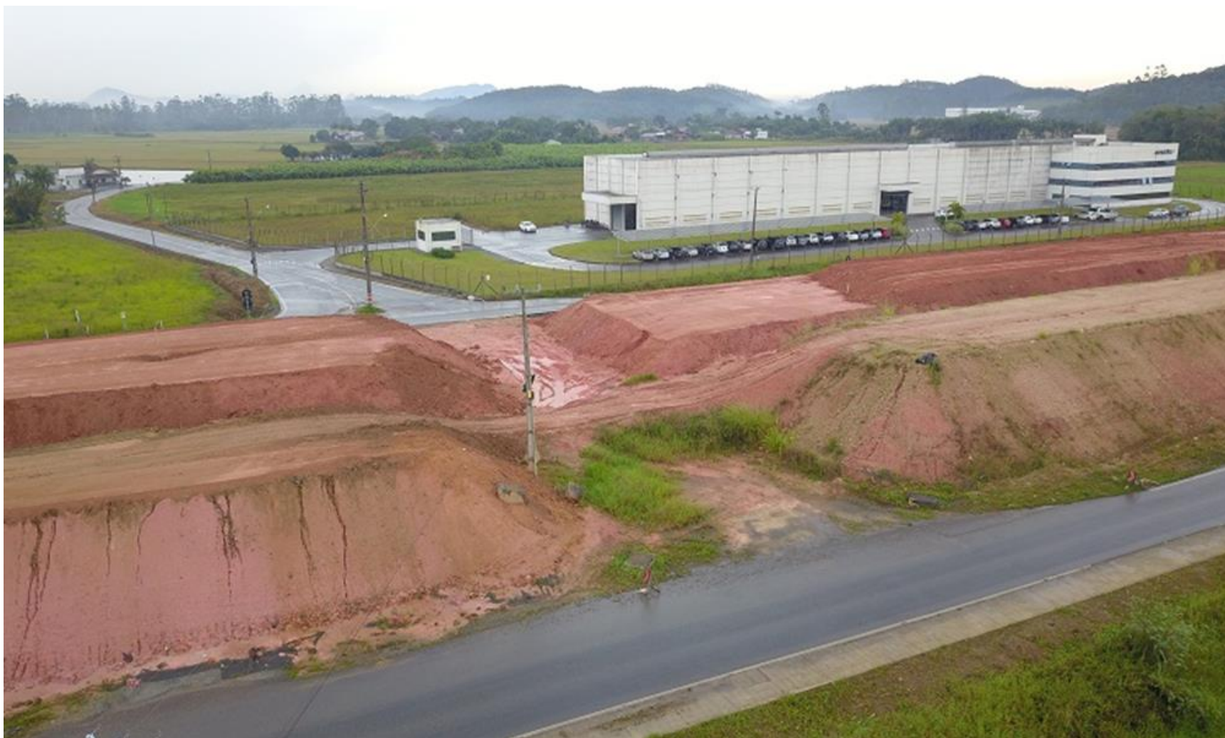
31 – Obras para Construção do Viaduto no KM 46,7.
