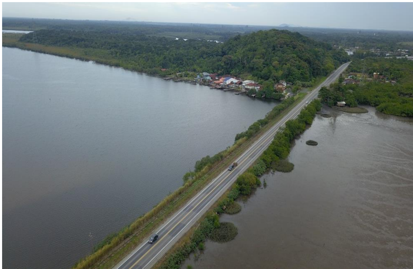
22 – Vista do 1º Aterro Rodoferroviário
