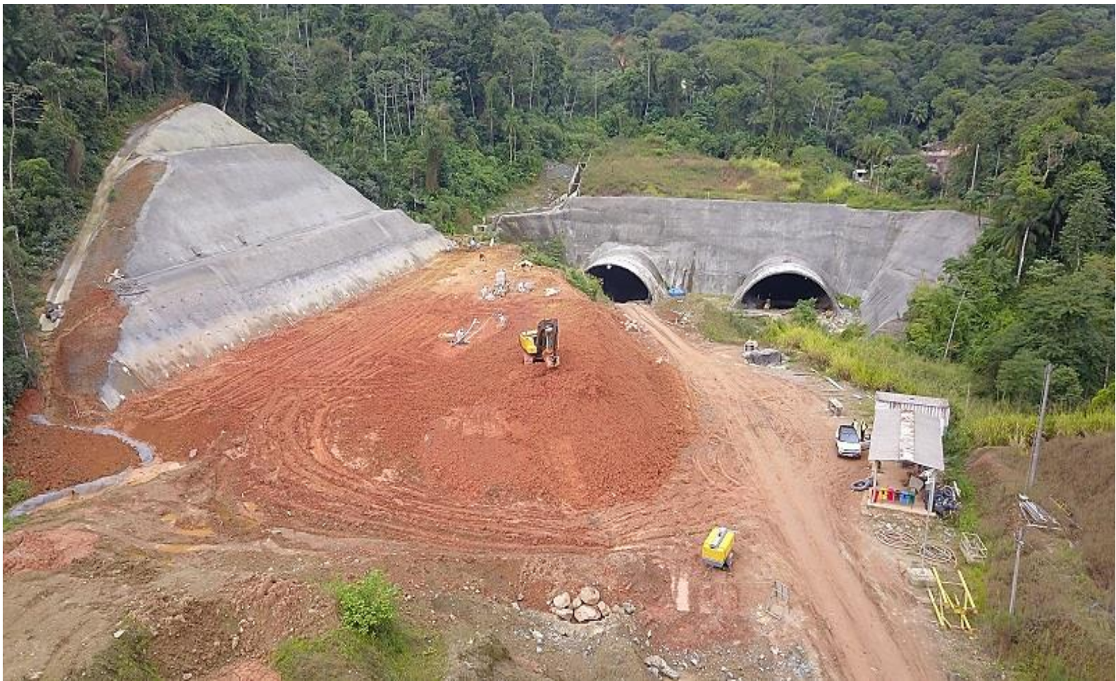
55 – Embocamento “OESTE” – KM 66,680 – Observa-se o Corte, em “Meia Encosta”, Executado.
