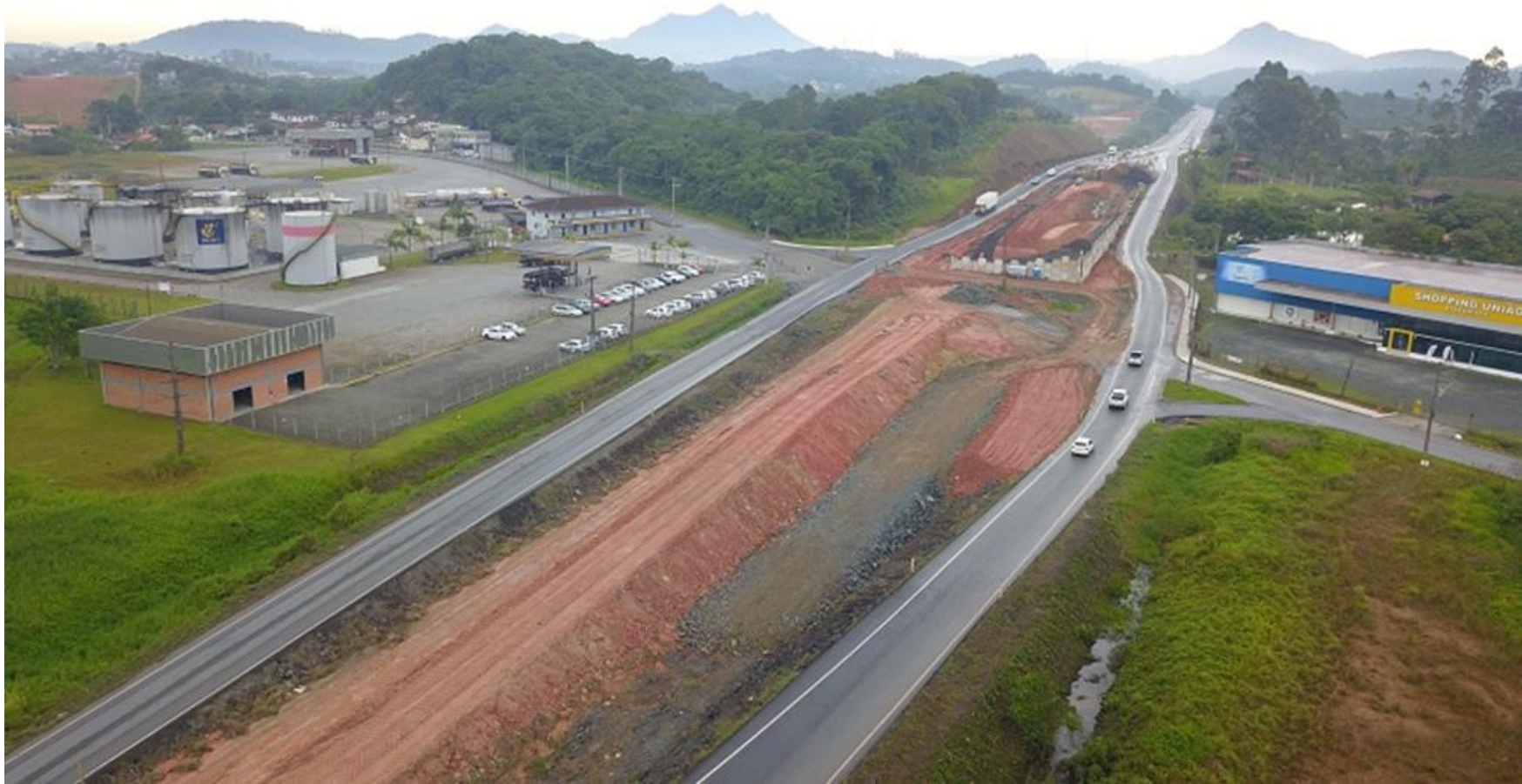
34 – Passagem em desnível, em execução, para novo acesso ao terminal da Transpetro (Poço Grande).
