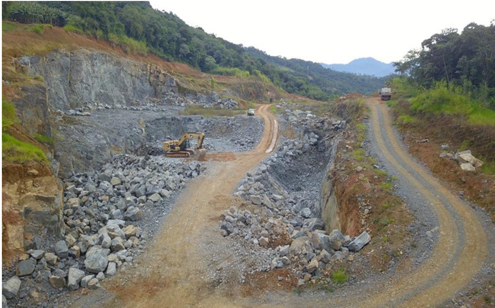
42 – Observa-se o Volumoso Corte “Caixão” em Rochas, sendo executado.
