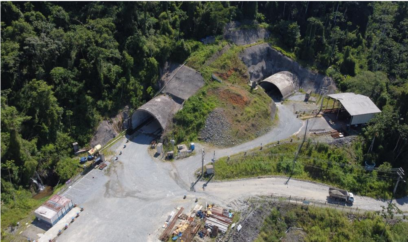
51 – Embocamento “Leste” do Túnel, em João Pessoa – KM 65,68
